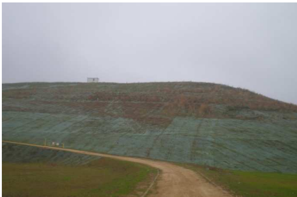
Ryc. 8. Składowisko odpadów komunalnych „Maślice” w trakcie rekultywacji (fot.Dominika Wawrzyniak)
